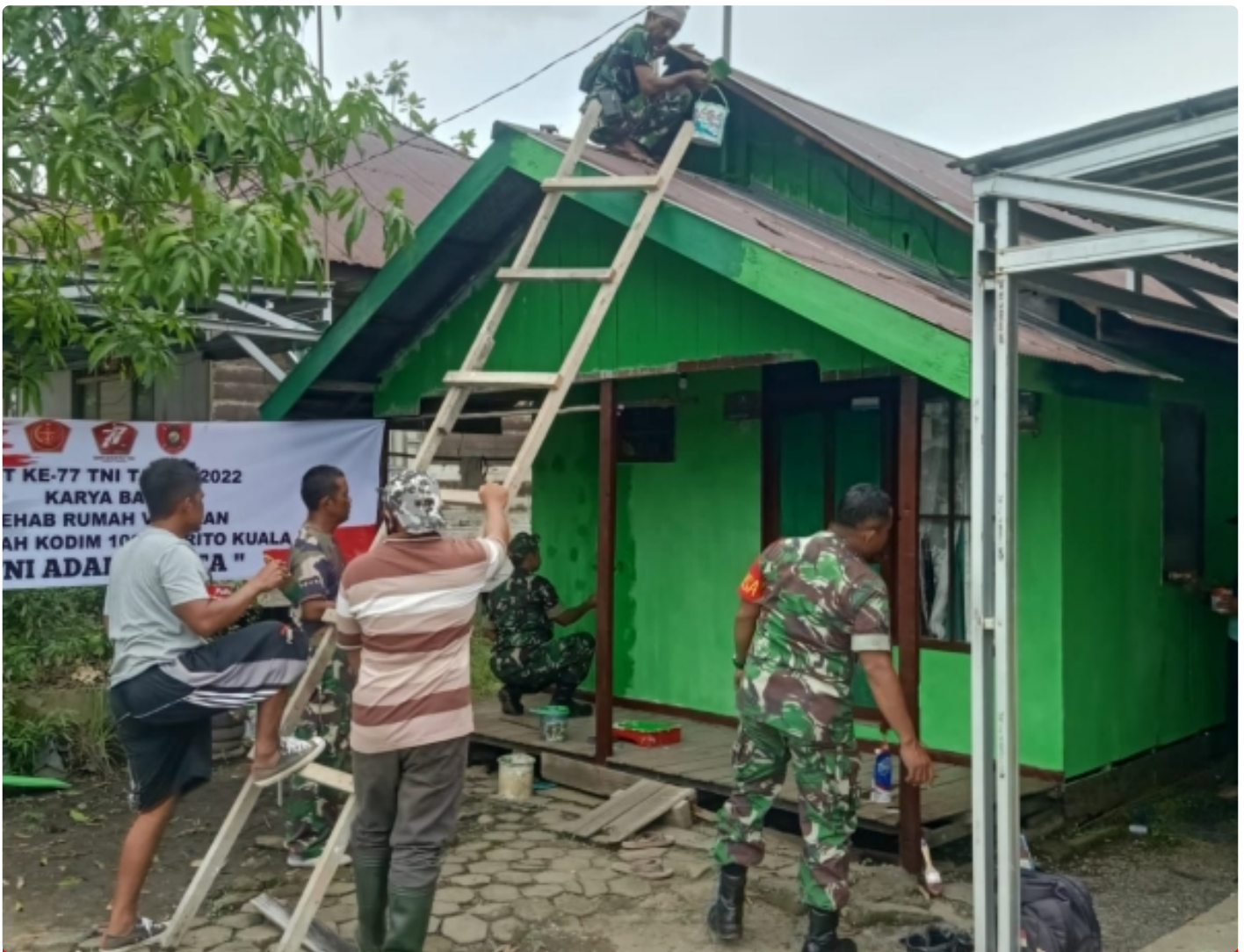
Anggota Kodim 1005/Barito Kuala Rehab Rumah Veteran
