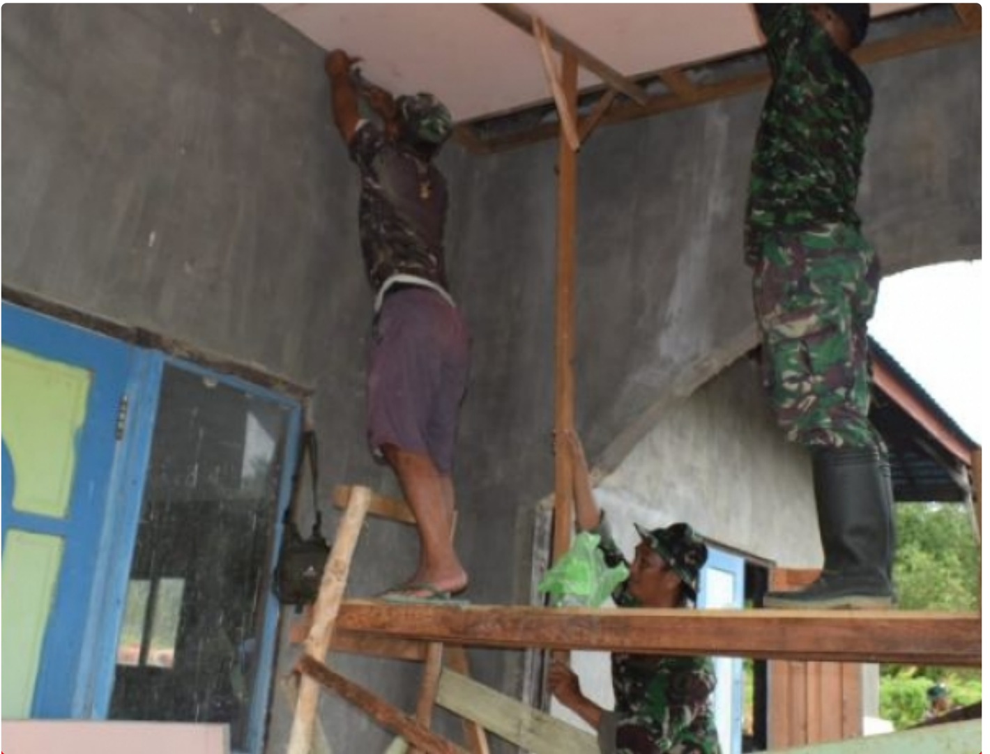
Anggota Satgas tMMD Pasang Plafon Masjid
